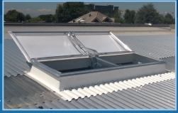
Evacuatore naturale di fumo e calore tipo ELECTRIC COVERSMOKE
